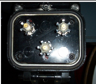
Рис. 2.8.7 Розетка ввода в депо 380В
