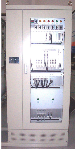
Рис. 2.3.13. Внешний вид микропроцессорного шкафа
