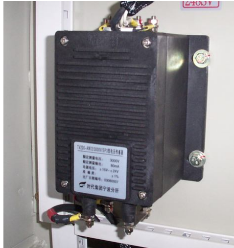
Рис.18.1 Внешний вид датчика напряжения типа TV200-AW/2/SP3
