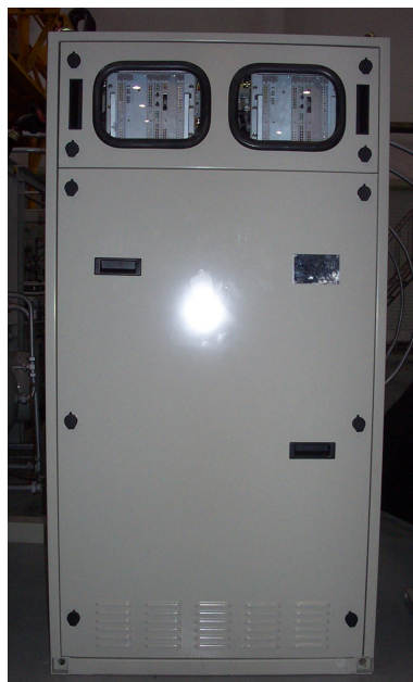
Рис. 2.3.8. Внешний вид шкафа вспомогательного трансформатора тока
