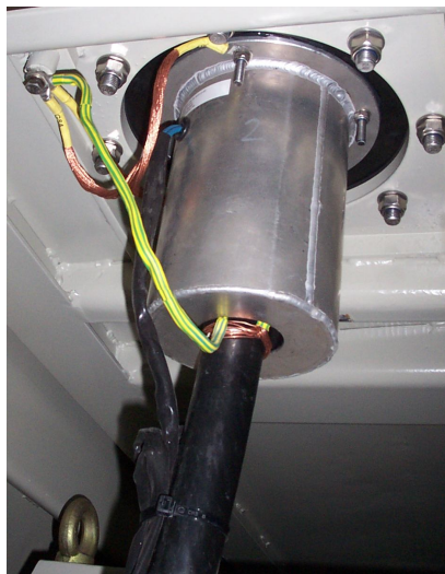
Рис. 2.4.10. Соединение высоковольтных кабелей 25кВ с высоковольтным датчиком тока
