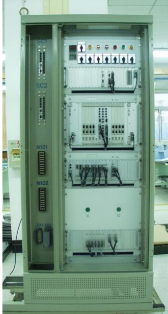
Рис. 3 Центральный микрокомпьютерный контрольный шкаф
