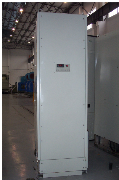
Рис. 2.3.10. Внешний вид шкафа кондиционеров
