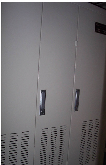
Рис. 2.3.12. Внешний вид шкафа безопасности
